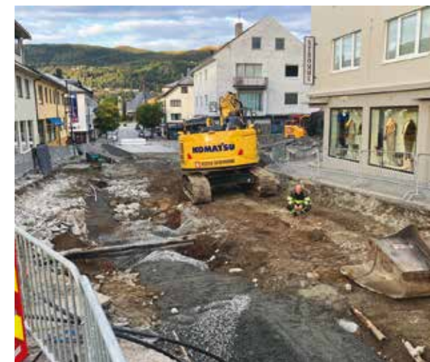
Det er av og til gravearbeid i sentrum. I haust har delar av Kyrkjevegen vore sperra av for å leggje betre til rette for mjuke trafikantar i sentrum og for å skape eit heilskapleg gatemiljø.
