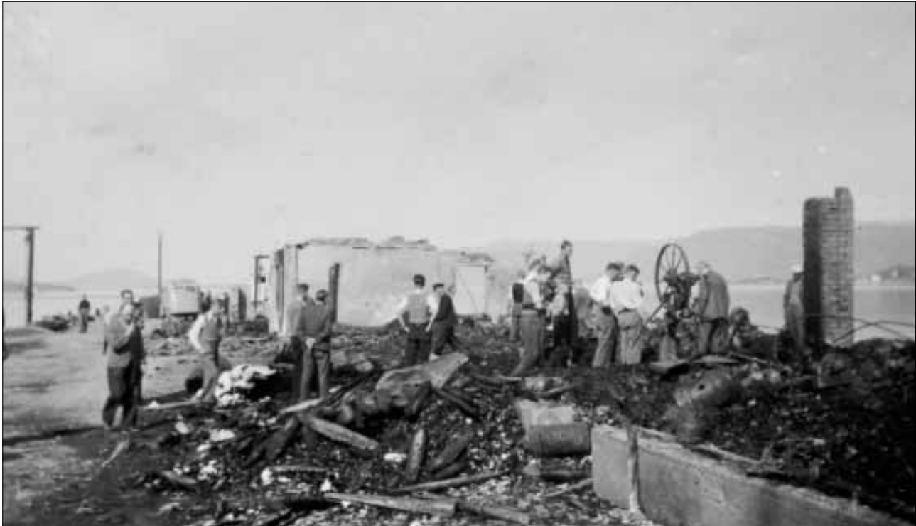
Branntomta til Vestlandske søndag 20. august. Mange var nok usikre på framtida når arbeidsplassen deira såg slik ut!
