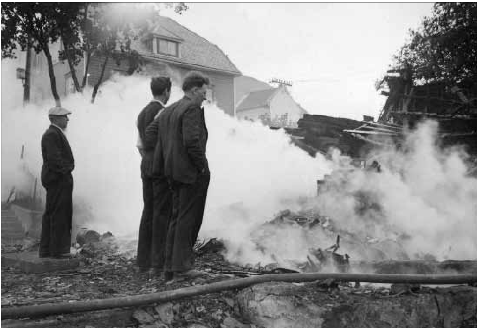
Frå venstre: Anton Roald, ukjend og Ludvik Hole ser på restane av B.S. Aure sitt hus.
